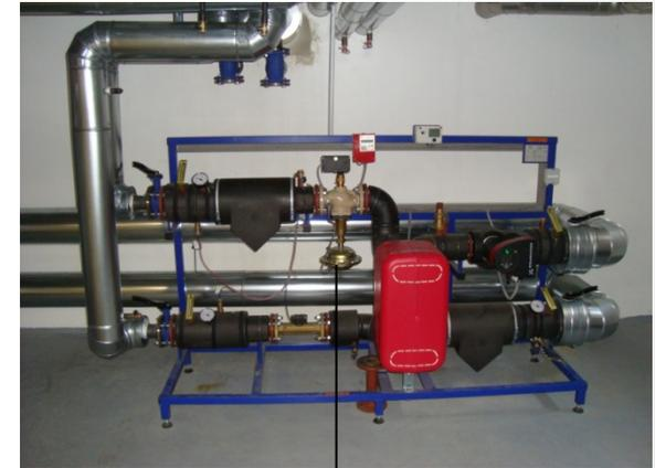
Übergabestation für die Fernwärme der Biogasanlage
