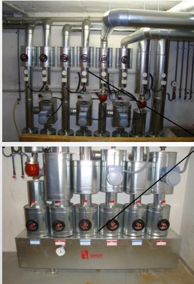
Sanierung der Heizungsverteiler im Hauptgebäude, Düserbau und Kuckbau aus 2012 inkl. PC-Steuerung der einzelnen Heizkreise
