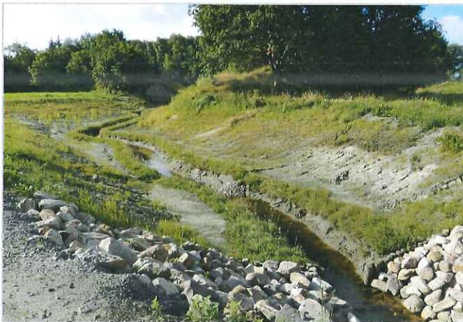
Doppeltrapezprofil mit eingebrachtem Kies
