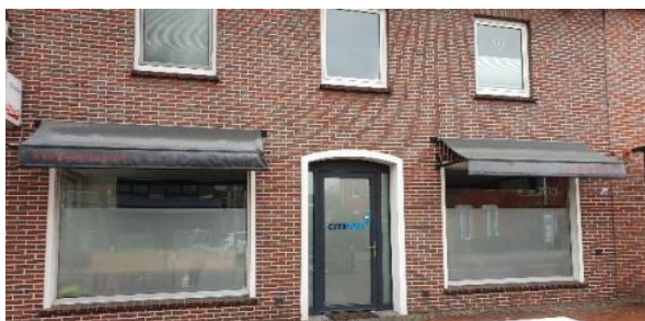
Hauptstraße 26, Ansicht von Hauptstraße (aktuelle Nutzung Aufnahme 2026)
