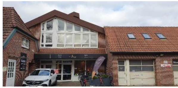
Kirchstraße 2 (aktuelle Nutzung Aufnahme Februar 2026)
