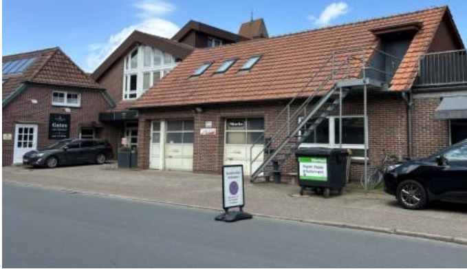
Hauptstraße 26, Ansicht Kirchstraße Aufnahme Mai 2024
